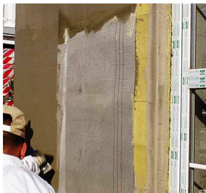
приклеивание армирующей сетки с помощью Satex B Fix
