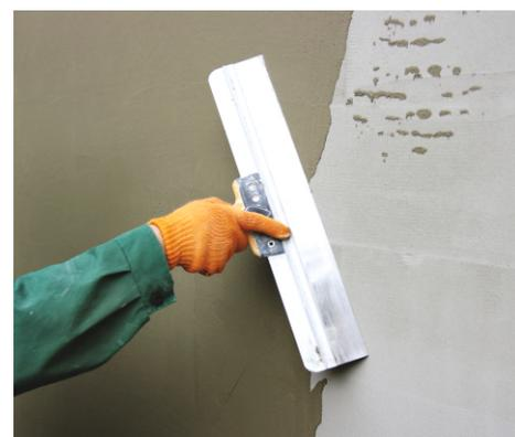
4) Сверху армирующей сетки Sate Mesh наносится специальная штукатурка для теплоизоляционных панелей Satex B Plus
