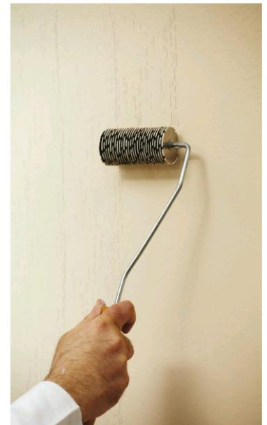
6) Вместо Satex Deco Putz как последний слой, можно покрасить поверхность с помощью фасадной краски на силиконовой основе Satex Farbe SL.
